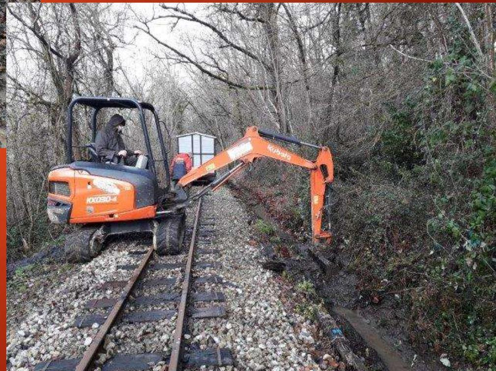
Il restait un stock de ballast à Salles. Il a été utilisé en janvier pour terminer l'évitement et assurer un complément dans la montée du PN de Giroussens malmené par le passage de quad ainsi qu'au-delà du PN.
